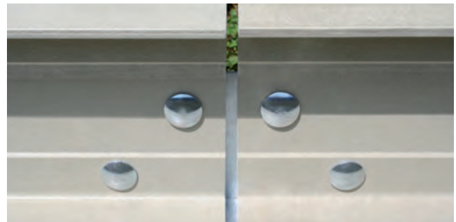
Винты с полукруглой головкой, необходим компенсационный зазор
