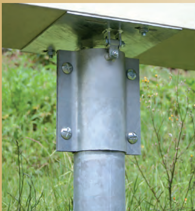
Шарнирная опора, регулируемая в 3 направлениях
